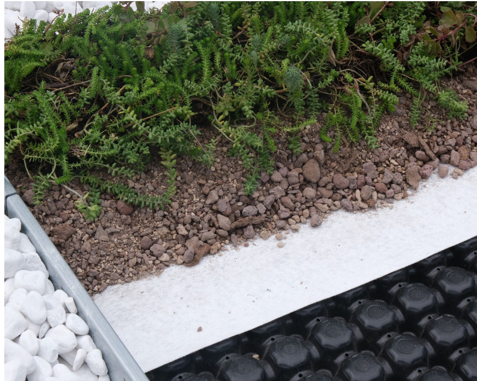
TETTO VERDE, PARTICOLARE SISTEMA E SUBSTRATO
